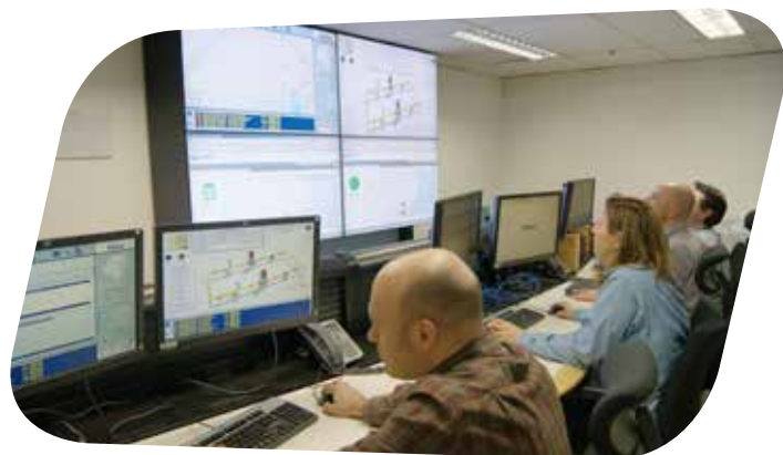
Sala de controle do Sistema Supervisório
